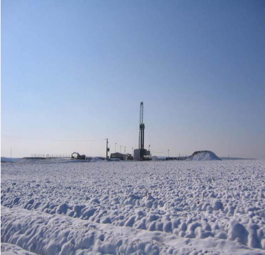
Szénhidrogén kút kiképzése hévíztermelésre
