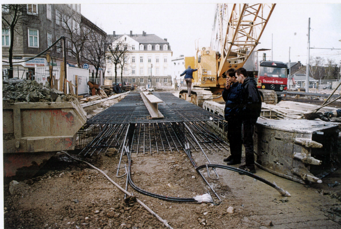
Thermoaktivált, energia nyerő résfal vasalás
