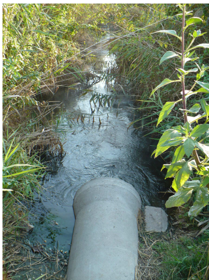
2.2. kép: Földmedrű csatorna Cserkeszőlő határában
